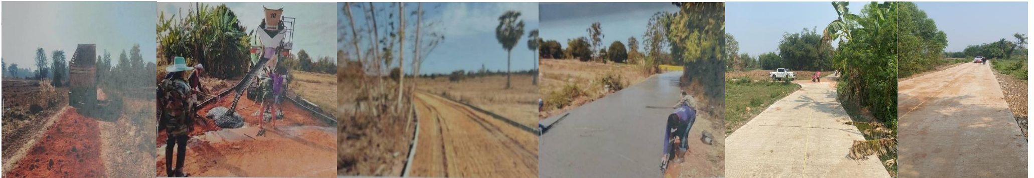
โครงการก่อสร้างถนนคสล. หมู่ที่ ๑๒ ซอยท่าข้าม บ้านโคกพลวง
