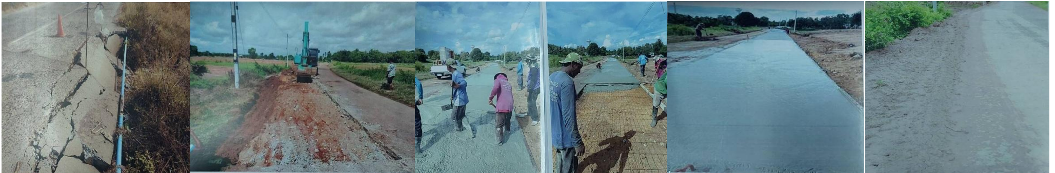
งานซ่อมแซมถนนคอนกรีตเสริมเหล็ก ทางเข้าบ้านกุดจอกน้อย หมู่ที่ ๖ บ้านกุดจอกน้อย
