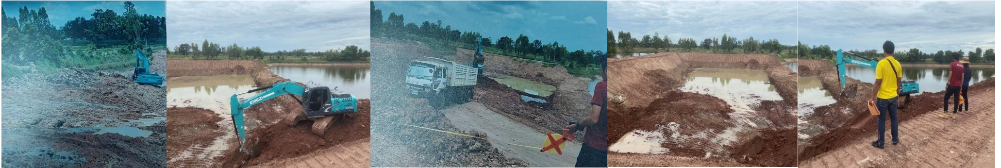
โครงการขุดลอกสระน้ำสระประปา หมู่ที่ ๘
