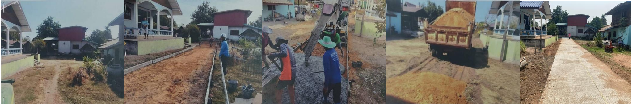
โครงการก่อสร้างถนนคสล. ซอยบ้านสุนทร ทันนวัตร หมู่ที่ ๓ บ้านละลม
