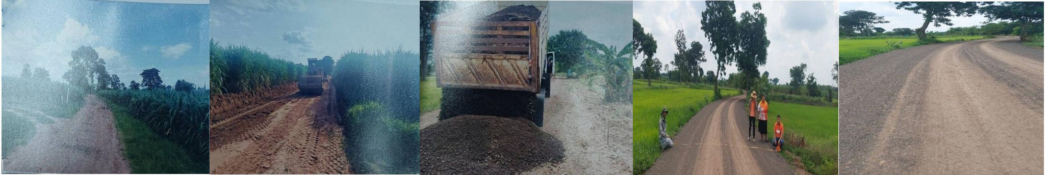
โครงการปรับปรุงถนนหินคลุกต่อจากถนนคอนกรีตเสริมเหล็ก จากหน้าวัดสระตะหมก ถึงหนองกระโดน หมู่ที่ ๕ บ้านสระตะหมก
